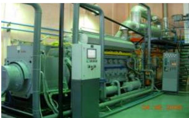
Рис. 2. Опытно-промышленная установка на Белгородском комбинате ЖБК
