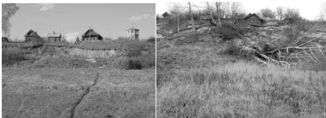
Рис. 1. Обвальнo-оползневой уступ на участке активизации древнего оползня вдоль южной окраины д. Воробьецово: левый берег р. Волги, ниже впадения в нее р. Меры
