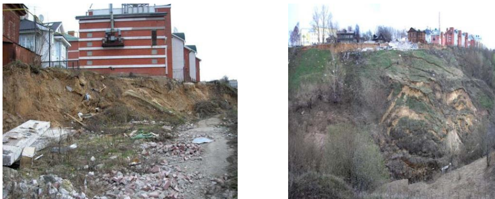
Рис. 3. Оползень в Большом Красном овраге в Нижнем Новгороде 5 апреля 2008 года
