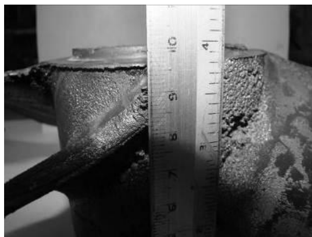
Рис. 9. Разрушение ступицы колеса
