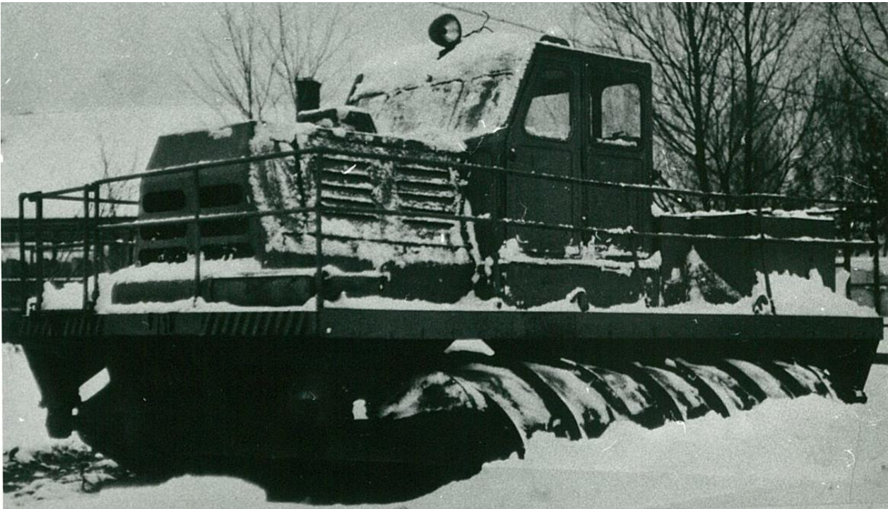
Рис. 35. Снегоболотоход на РВД разработки МИНХ им. Губкина
