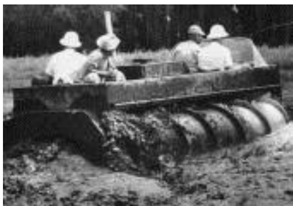
Рис. 23. Испытания Marsh Screw на заиленной местности
