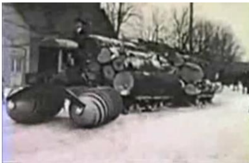
Рис. 30. Трактор Fordson, оснащенный РВД на вывозке леса (1927-1929 гг.)
