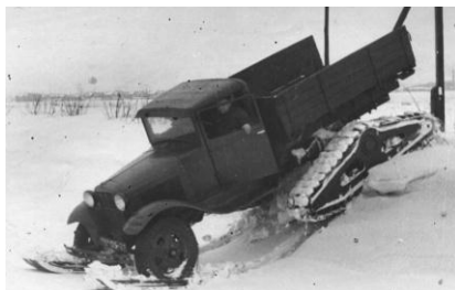
ГАЗ СХ полугусеничный грузовик 1942 г.
