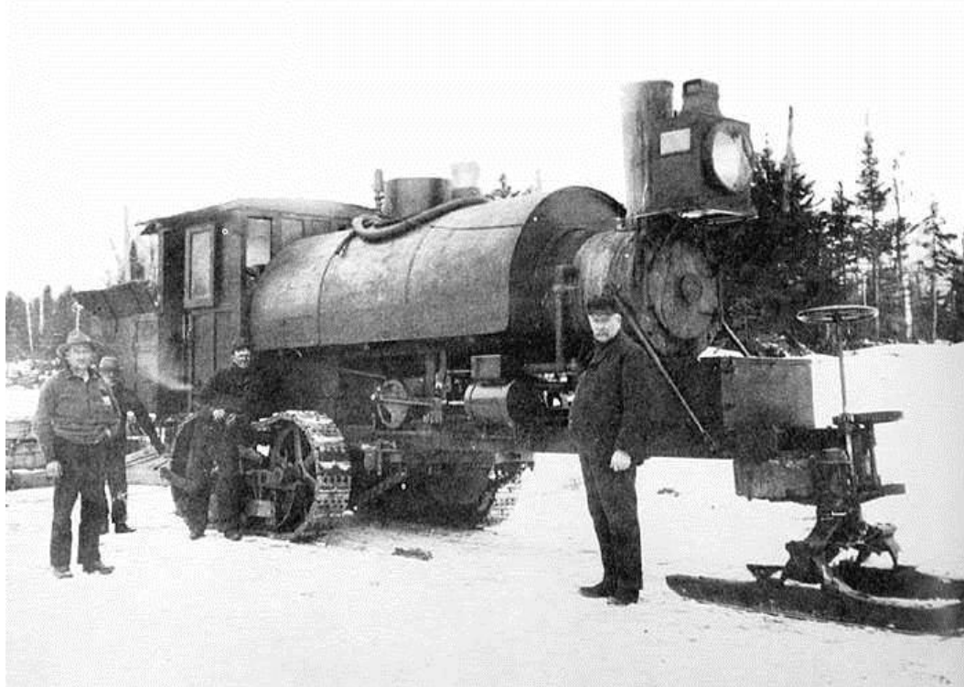
Рис. 27. Паровой снегоходный трактор Элвина О. Ломбарда «Lombard Log Hauler» (1901 г.)
