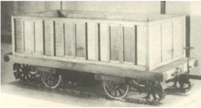
Рис. 21. Гусеничный вагон-прицеп конструкции Блинова
