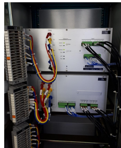
Рисунок 91 – Обратная сторона шкафа с усилителями
