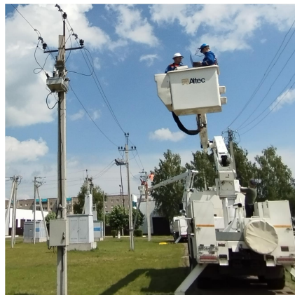
Рисунок 114 – Процесс тестового включения комплекса мониторинга ВЛ 10 кВ
