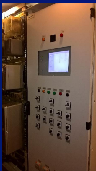
РЗА на ЛЭП 110 кВ «Пуголи- Нармонка»
