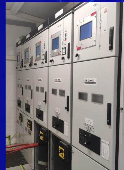
РЗА 6-35 кВ на объекте РТП №12 (РУ-6 кВ)
