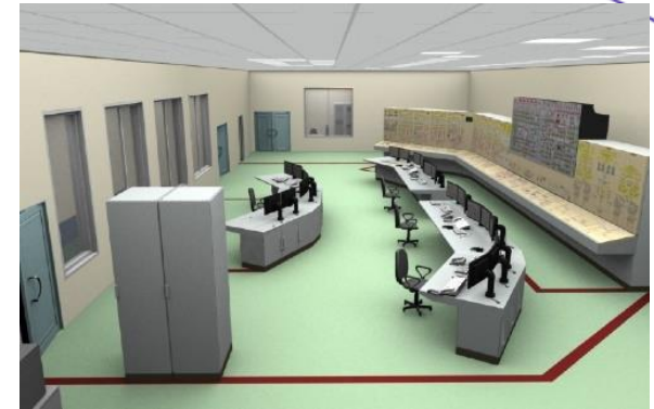
Зал, оснащенный ЧМИ БПУ АЭС
