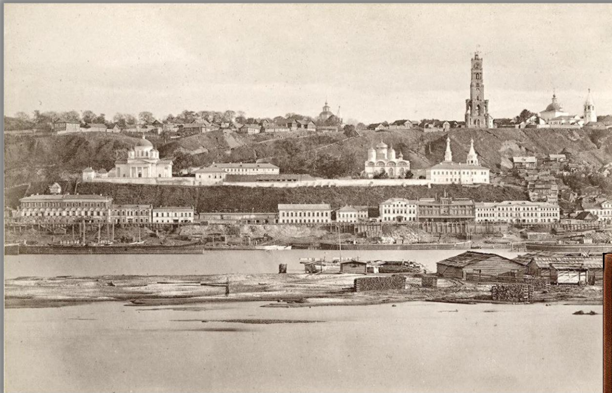
Вид на Благовещенскую слободу с ярмарочной стороны
