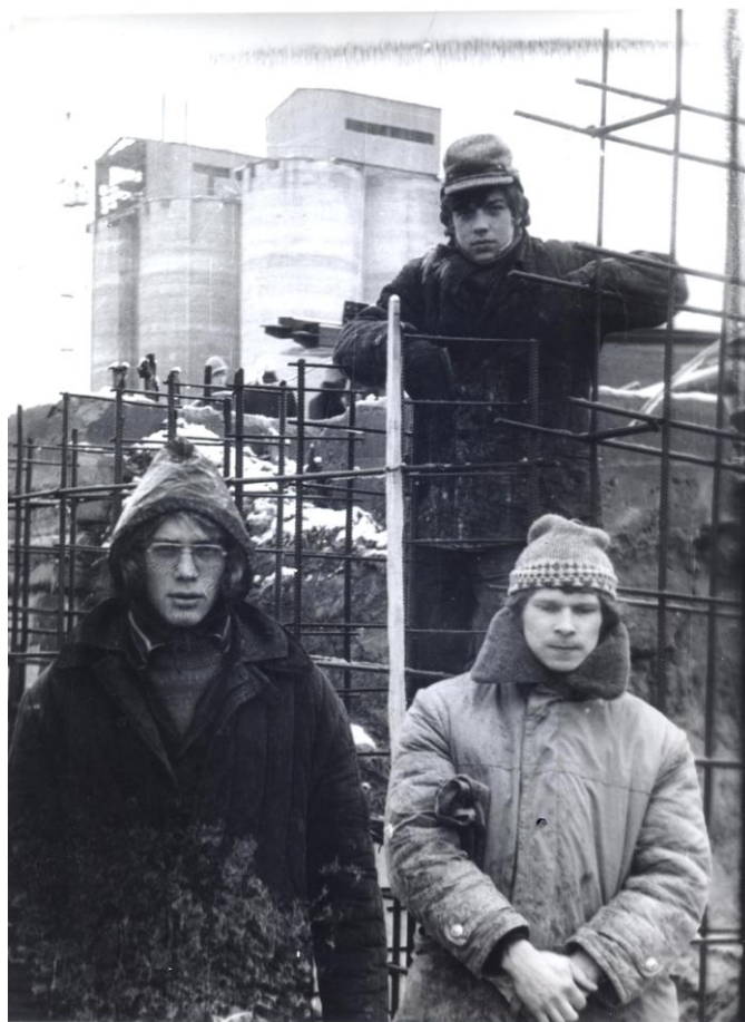
Бойцы стройотряда на строительстве элеватора в Горьковской области (80-е гг. XX в.)
