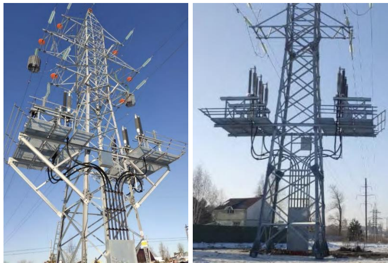
Рисунок 1.3 – ПП на опоре с эксплуатационной площадкой [www.streamer.ru]
