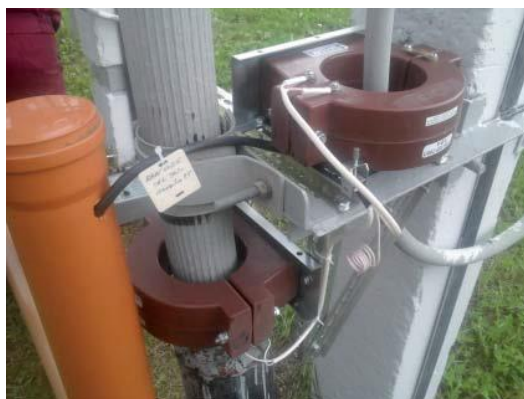
Рисунок 1.8 – ТТ с размыкаемым сердечником, подключенные поверх кабеля и поверх проводника заземляющего устройства [23]
