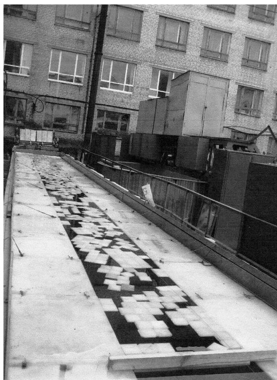
Рис. 6. Общий вид ледового бассейна. Ледовый канал переменной ширины
