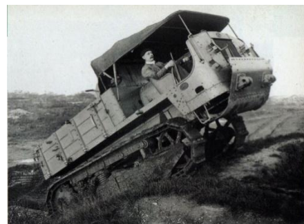
Рис. 80. Транспортёр «Шнейдер» (1917 г.)
