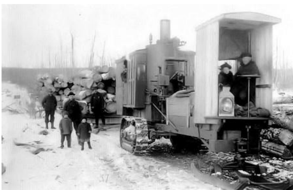
Рис. 29. Паровые полугусеничные снегоходы начала XX в.
