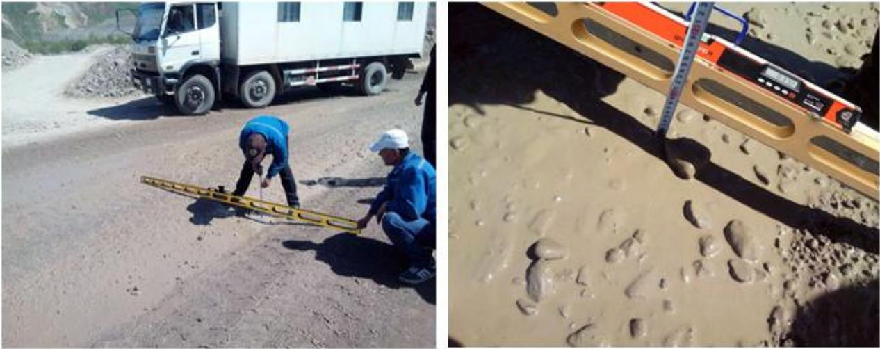
Рис. 4. Измерение неровностей карьерной дороги при помощи универсальной дорожной рейки РДУ «Кондор»
