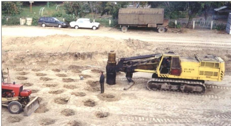
Рис. 3. Агрегат для глубинного трамбования грунта
