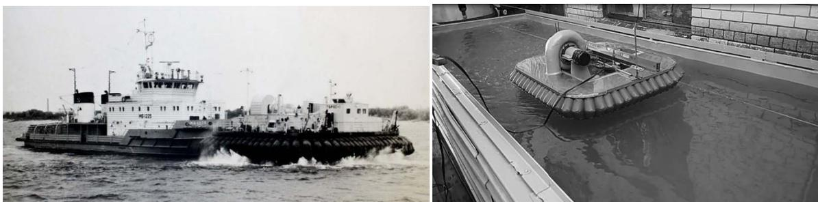
**Рис. 4. Испытания ледокольной платформы на воздушной подушке**
