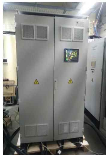
Рисунок 10 – Система бесперебойного питания СБП «ДУБНА»
