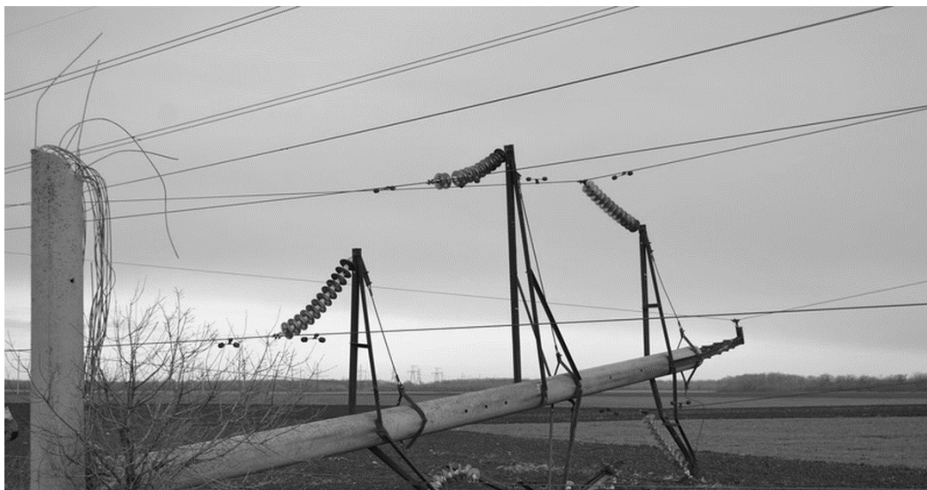
Рис.1 Обрыв провода
