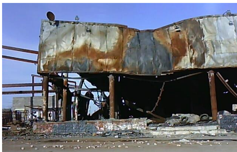
Рис. 5. Потеря несущей способности
