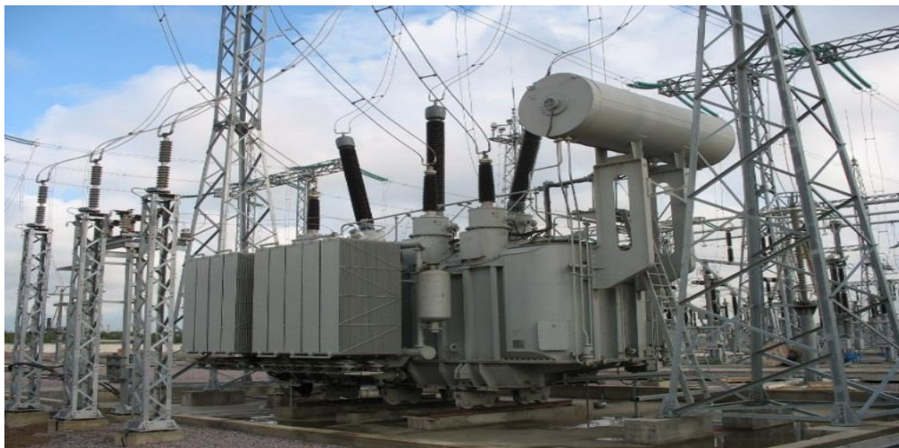
Рис. 3. Трансформаторы ОРУ
