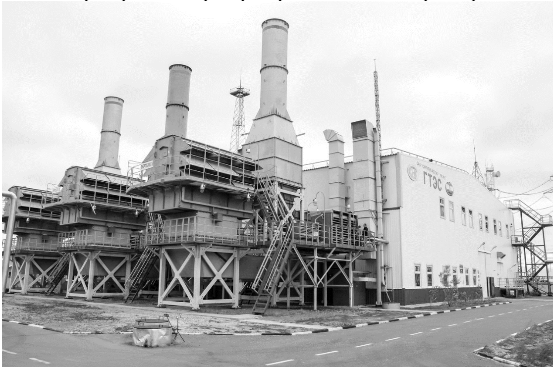
Рис.1. ТЭС с газотурбинными установками
