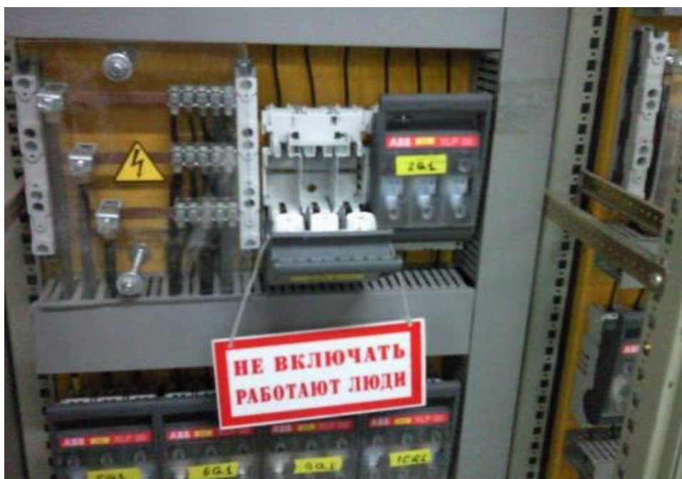
Рис. 7.4. Знак безопасности «НЕ ВКЛЮЧАТЬ РАБОТАЮТ ЛЮДИ»
