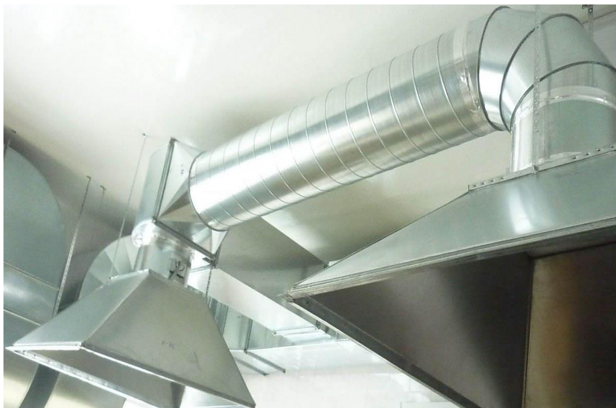
Рис. 5.32. Вытяжная вентиляция от места выброса пыли
