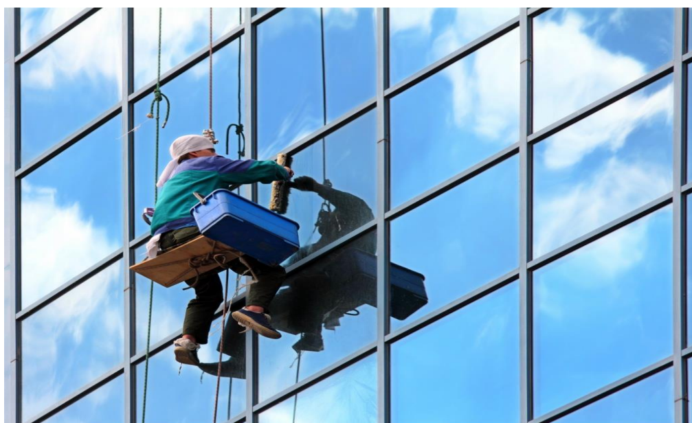
Рис.6.8. Чистка оконных проемов
