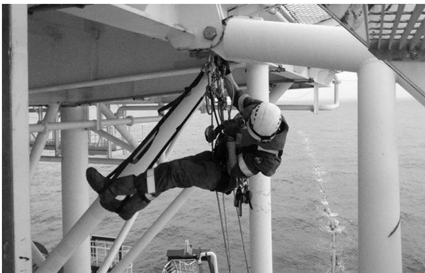
Рис. 2.18. Работа на высоте
