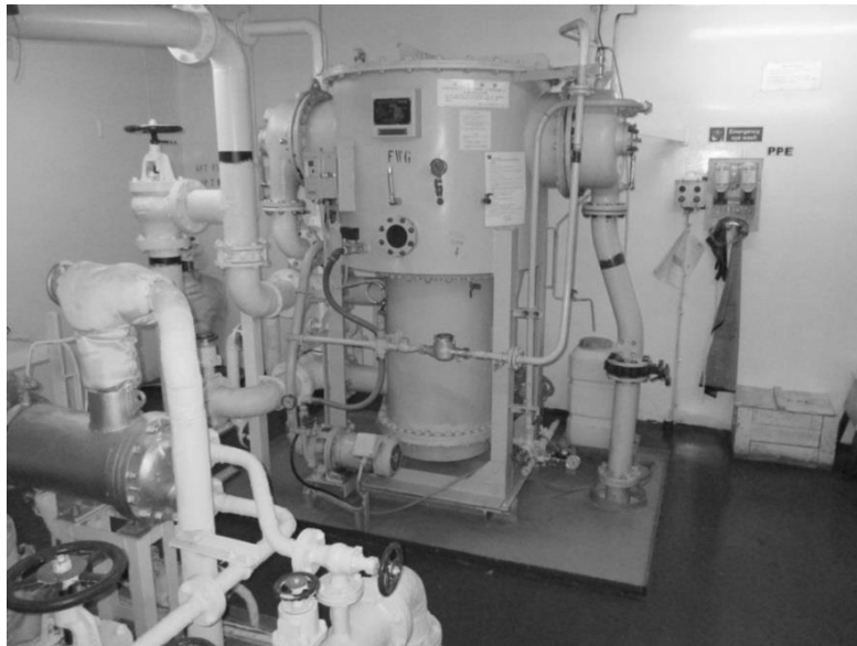
Рис. 5.2. Генератор пресной воды
