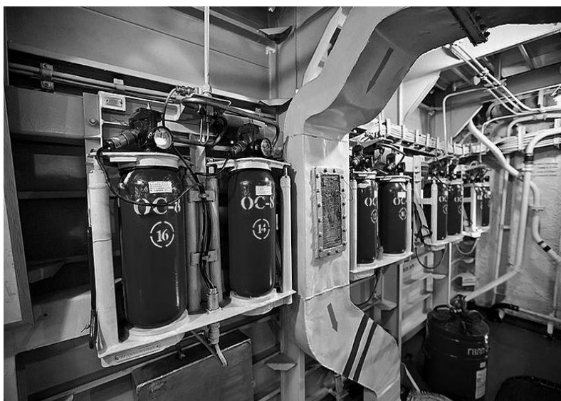
Рис. 8.5. Газовая система пожаротушения
