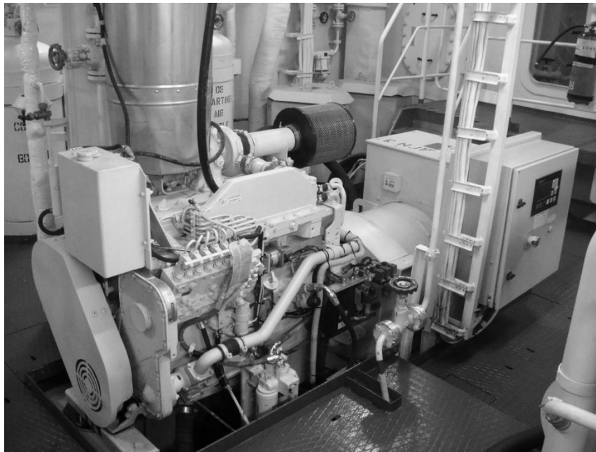
Рис. 7.1. Дизель-генератор
