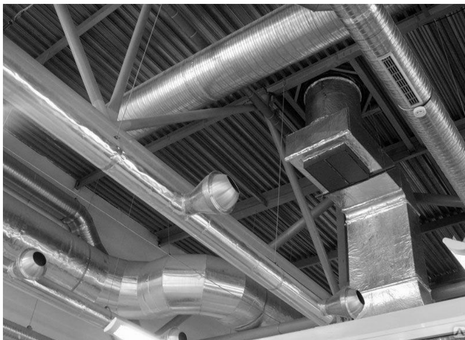
Рис. 5.1. Общеобменная приточная вентиляция
