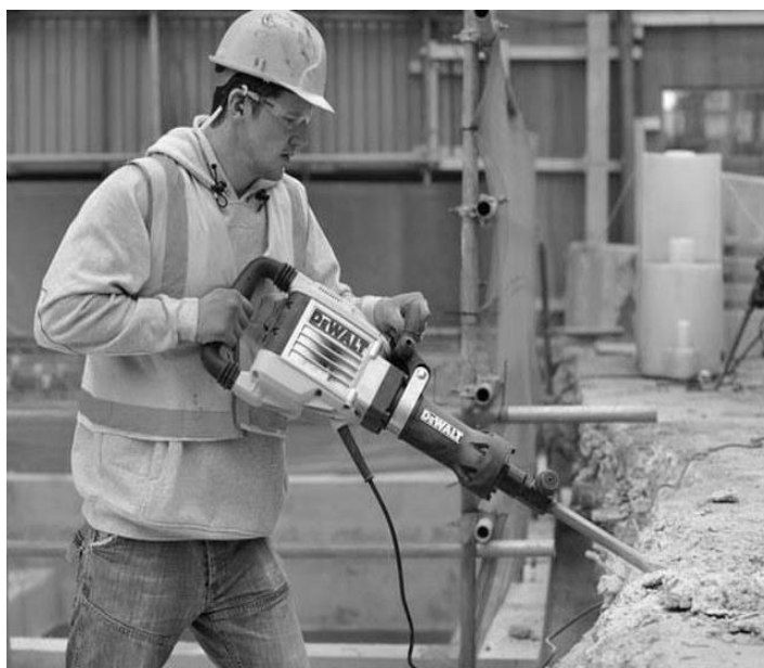
Рис. 5.2. Рабочее место – стройплощадка
