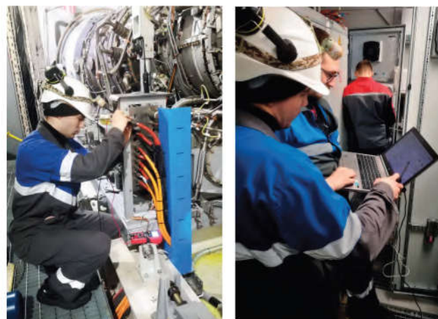
Молодой специалист за выполнением пусконаладочных работ системы управления газотурбинным двигателем АЛ-31СТ
