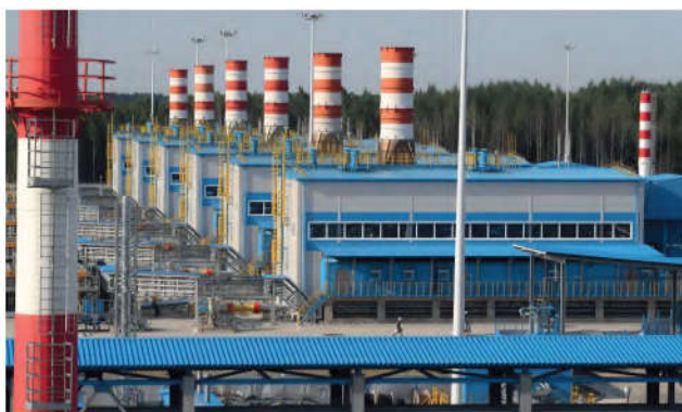
Газоперекачивающие агрегаты на КС «Славянская»
